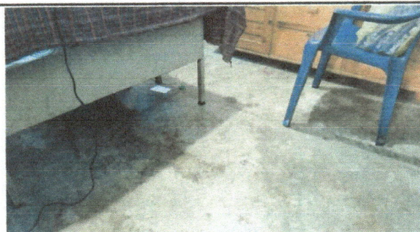
FOTO 4. CAMBIO DE PISO POR PISO CERAMICO
