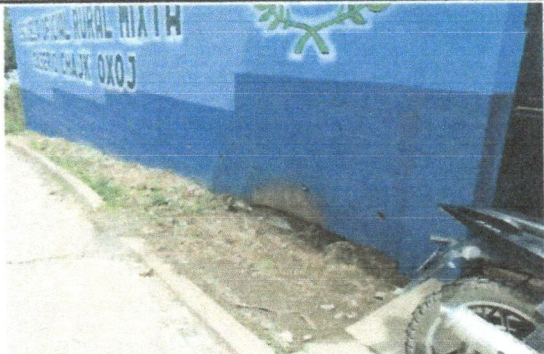
FOTO 7: REPARACION DE BANQUETA DE CONCRETO EXTERIOR LADO DERECHO
