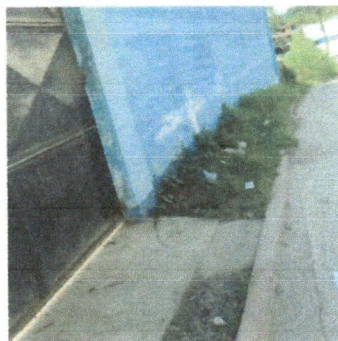
FOTO 8: REPARACION DE BANQUETA DE CONCRETO EXTERIOR LADO IZQUIERDO
