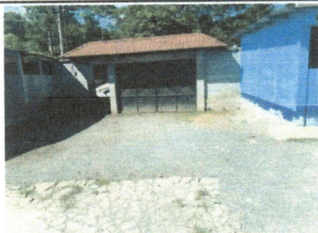
FOTO 5: CAMINAMIENTO DE LA ENTRADA PRINCIPAL
