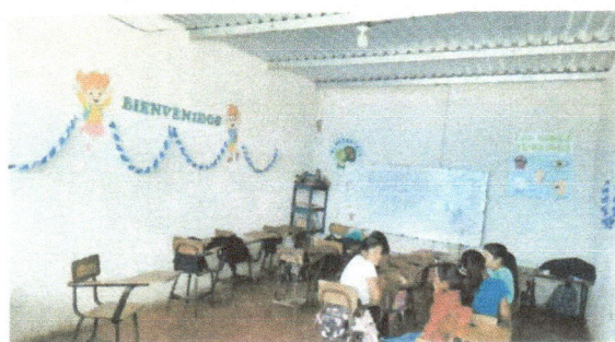
FOTO 3: APLICACION DE PINTURA DE AULAS INTERIOR
